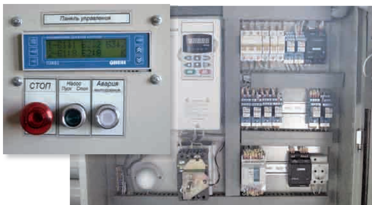
Фото 2. Внешний и внутренний вид шкафа управления
