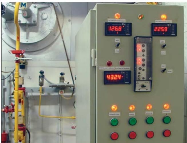
Фото 2. Шкаф управления хлебопекарной печью, работающий на приборах ОВЕН 2ТРМ1
