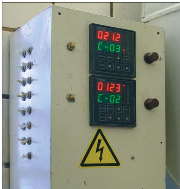
Фото 1. Измерители-регуляторы ОВЕН ТРМ38, управляющие пятнадцатью жарочными шкафами
