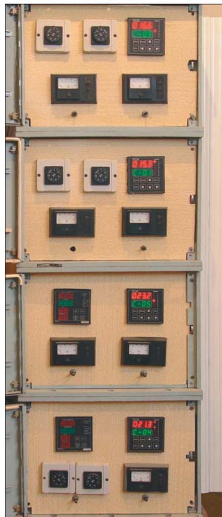
Фото 1. Щит управления температурой пастеризации, выполняемого перемещением вентиляционных заслонок
