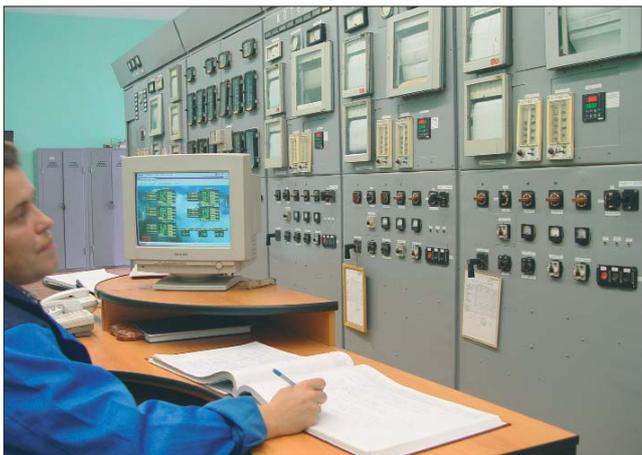
Фото 2. Щитовая, управляющая водогрейными котлами
