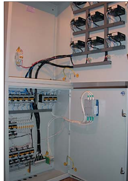
Фото 1. Два уровня шкафа управления ООО «Техстройсервис»
